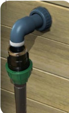
Starres abfallendes Rohr unter dem Reinigeranschluss
