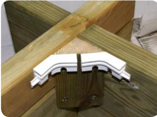
▶ Bringen Sie in jeder Ecke 2 Klemmpprofil-Eckstücke an. (Sie finden die Teile im Set Folie/ Abdichtung). Dazu ist es erforderlich, von jedem Eckstück die Verbindungszapfen zu entfernen. Achten Sie darauf, dass sich die beiden Eckstücke auf gleicher Höhe befinden und bündig mit der Beckenoberkante abschließen. Zwischen den beiden Eckstücken darf durchaus ein kleiner Spalt von wenigen mm bleiben. Verwenden Sie die Edelstahlschrauben 4x35 aus Beutel H.
