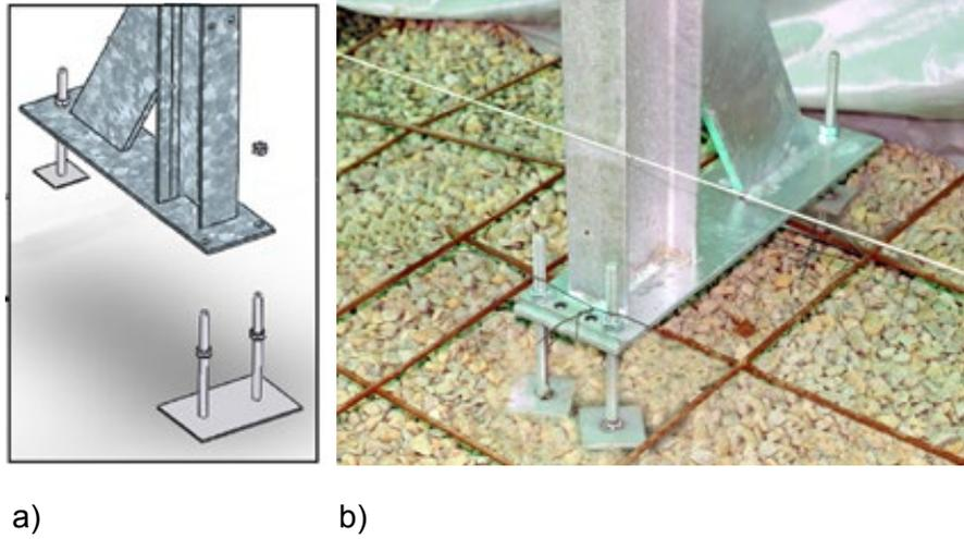
Abbildung 3 – a und b - Anbringen der Buchsen an den Streben
