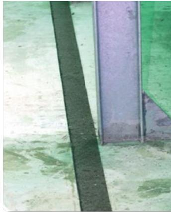
Abbildung 8 – Anbringen der Bitumenstreifen
